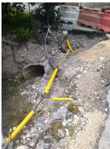
*Renouvellement de 68 m de canalisation suite à un incident provoqué par un effondrement de la chaussée du à une buse d'évacuation d'eau à Barraux*
