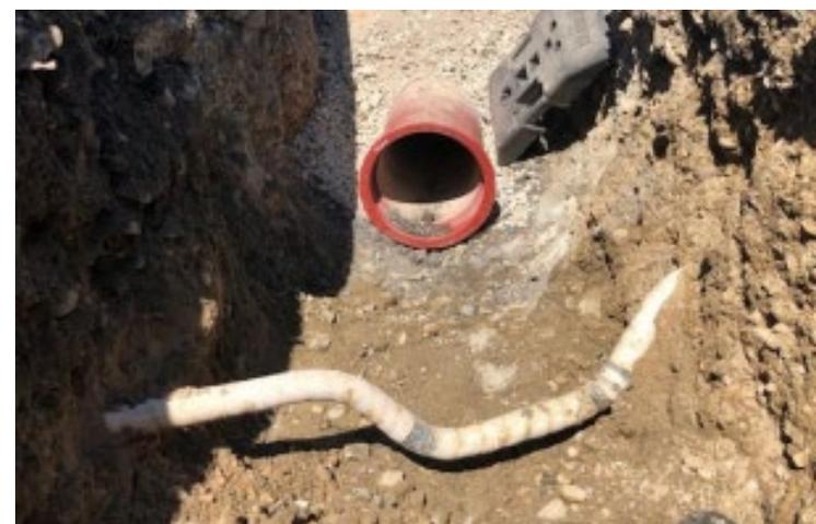
*Déplacement de 4 m de canalisation en acier de 48 mm de diamètre et exploitées en MPB à la demande de l'agglomération de Vienne pour la pose d'un assainissement*
