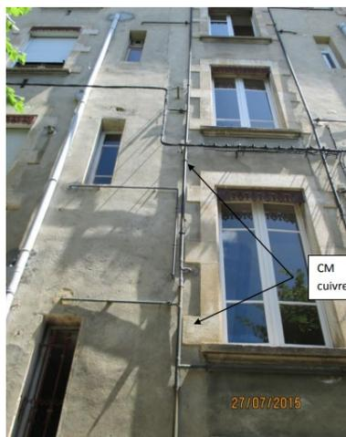
*Renouvellement de 2 conduites montantes et d'une conduite d'immeuble en cuivre dans un immeuble situé à Voiron*
