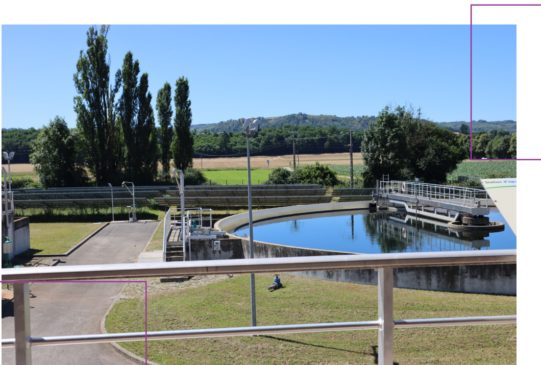
La station d'épuration et sa centrale photovoltaïque
