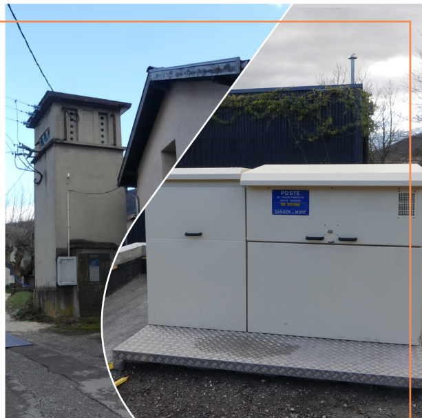
Remplacement d'un poste électrique à Jarrie
