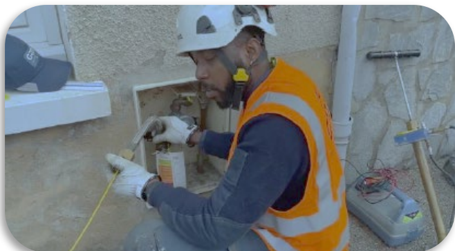
Pose d'un DPBE
