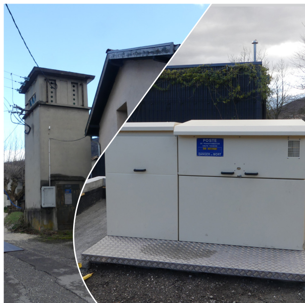
Remplacement d'un poste électrique à jarrie
