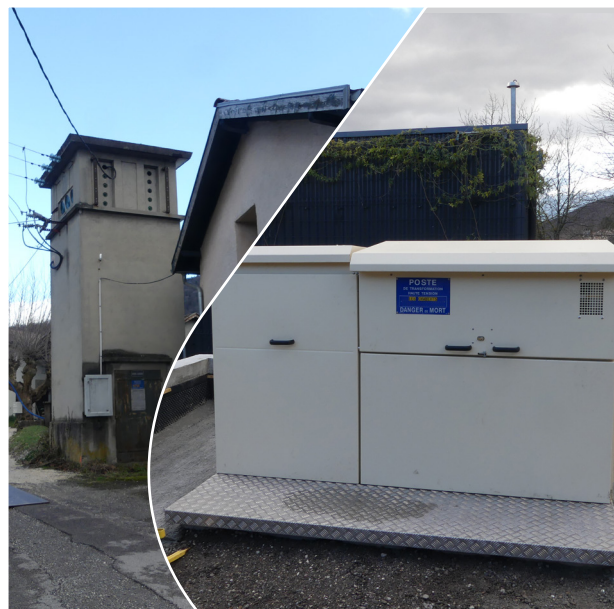
Remplacement d'un poste électrique à Jarrie
