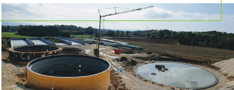
Construction d'une unité de biométhane à Saint-Victor-de-Morestel
