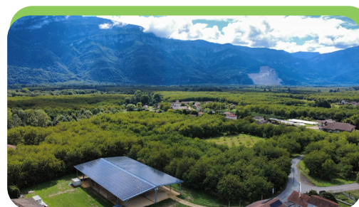
Poliènas Ombrières sur le boulodrome
