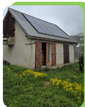
Installation d'une nouvelle centrale photovoltaïque
