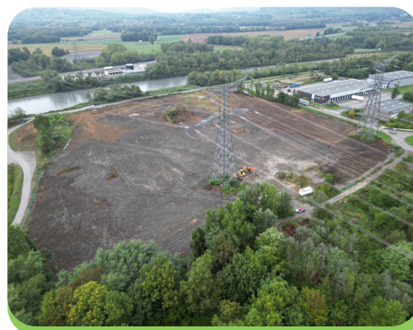
AlpCoeurEnergie Construction d'une centrale photovoltaïque au sol
